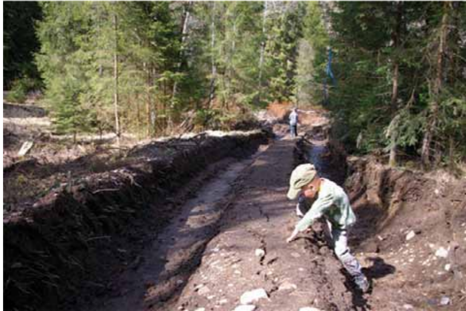
Hjulspåren går där det tidigare gick en stig.
